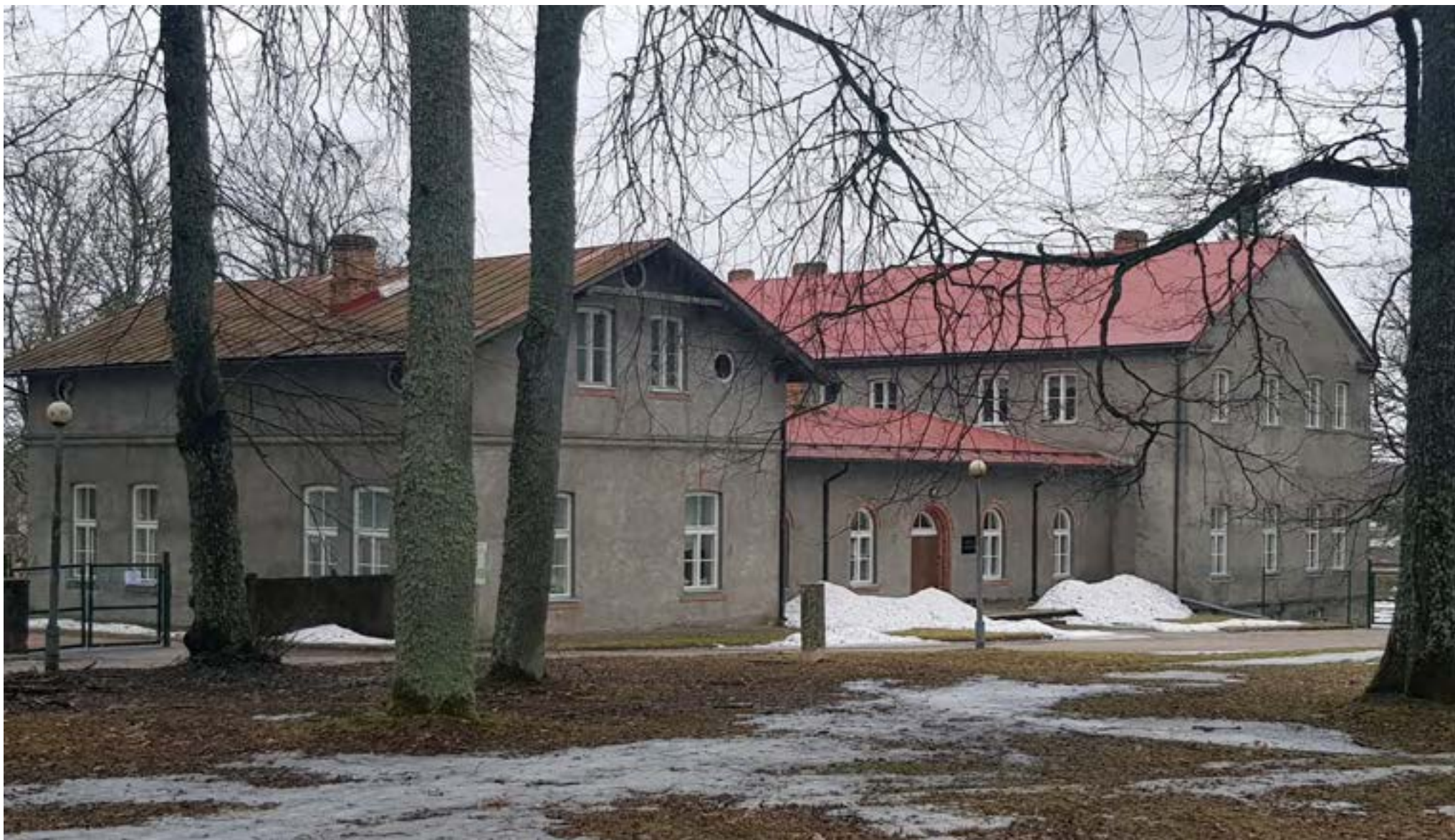
Foto 17. Lokuta mõisa peahoone. Ehitatud põhiosas 1875, mõned osad lisatud 1875-88. Parem tiib tehtud kahekorruseliseks 20. saj.
